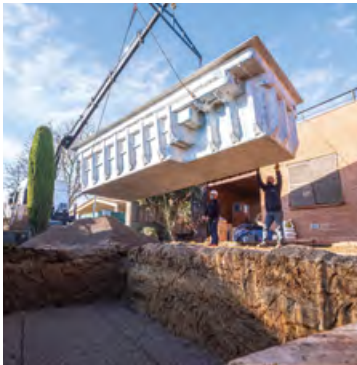
03. Colocación de la piscina en el agujero
