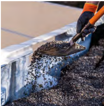
05. Rellenado de los laterales con grava
