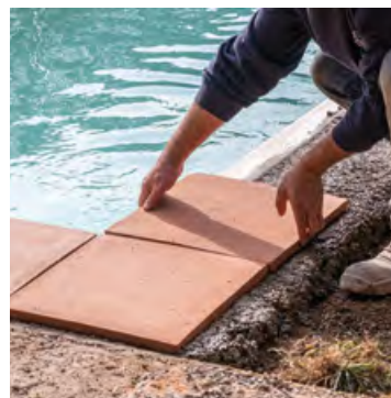
08. Colocación del borde perimetral
