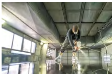
01. Preparación y acondicionamiento del molde
