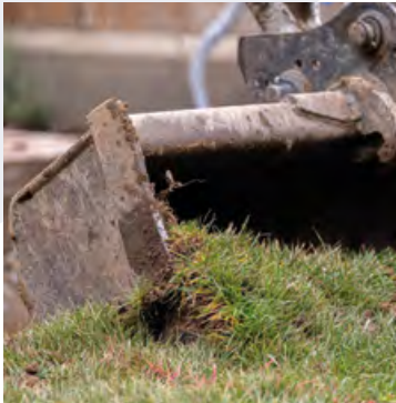
01. Excavación de la superficie de tierra
