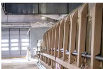
05. Colocación de refuerzos verticales y horizontales
