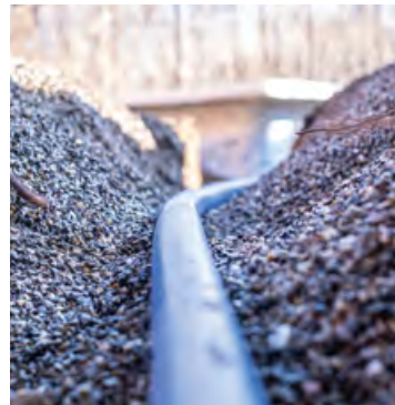
06. Instalación de tuberías
